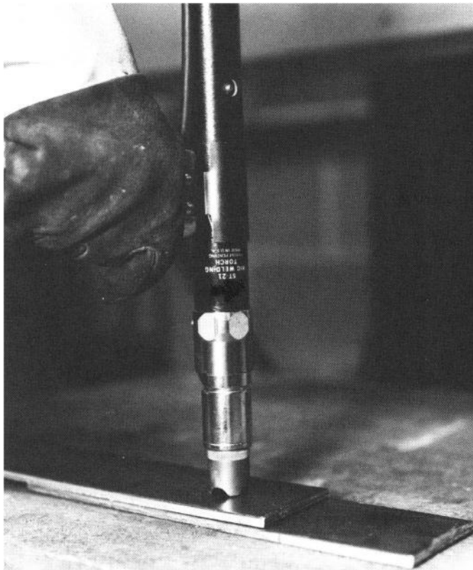
Figura 60 - Técnica de execução de uma solda pontual
