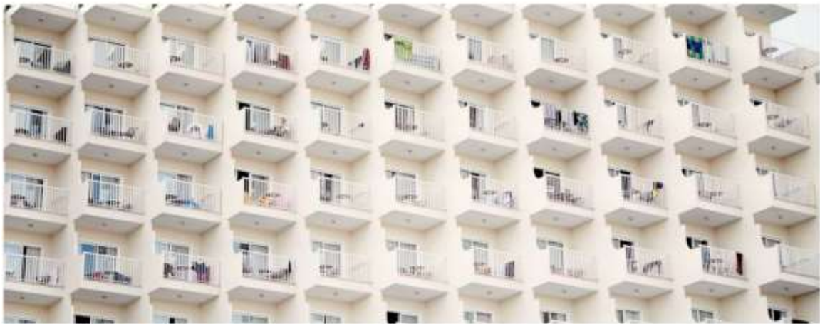
Bloco de apartamentos em Palma de Mallorca. FEDE SERRA
