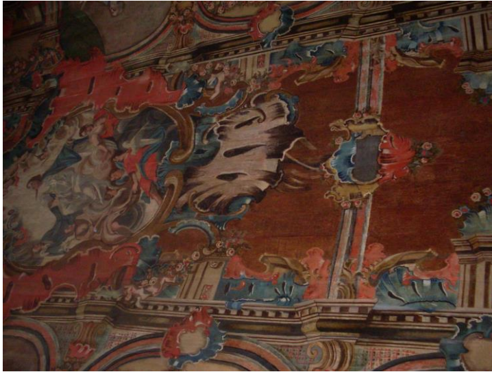
Imagem 14: Forro da nave da capela de Santa Efigênia, Ouro Preto
