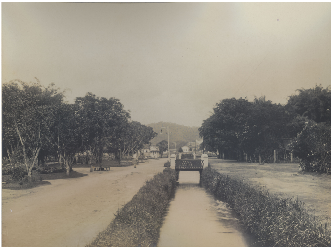
Imagem 8 – Vista do Bengo com as margens alinhadas. Parque das Águas de Caxambu, 1906. Fonte: Acervo fotográfico do Arquivo Público Mineiro, BH.
