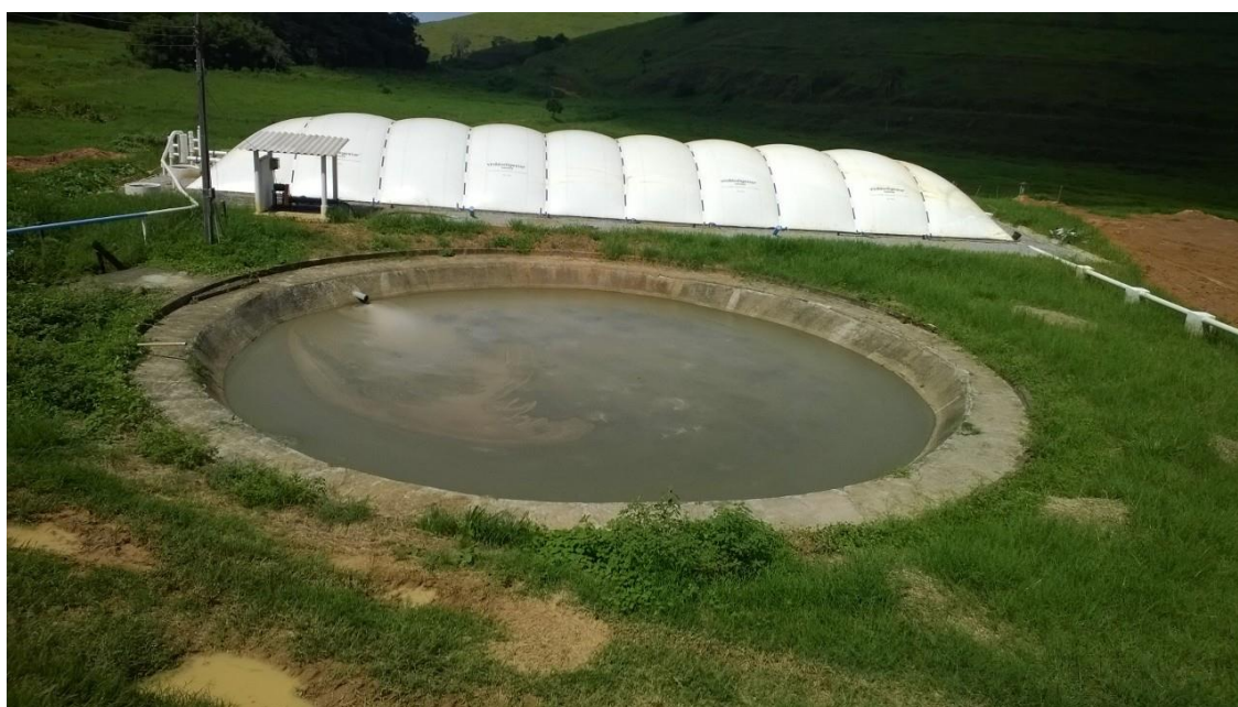
Figura 4: Biodigestor em escala real, modelo canadense, e lagoa de estabilização utilizados como pontos de coleta, situados no campo experimental da Embrapa Gado de Leite.
