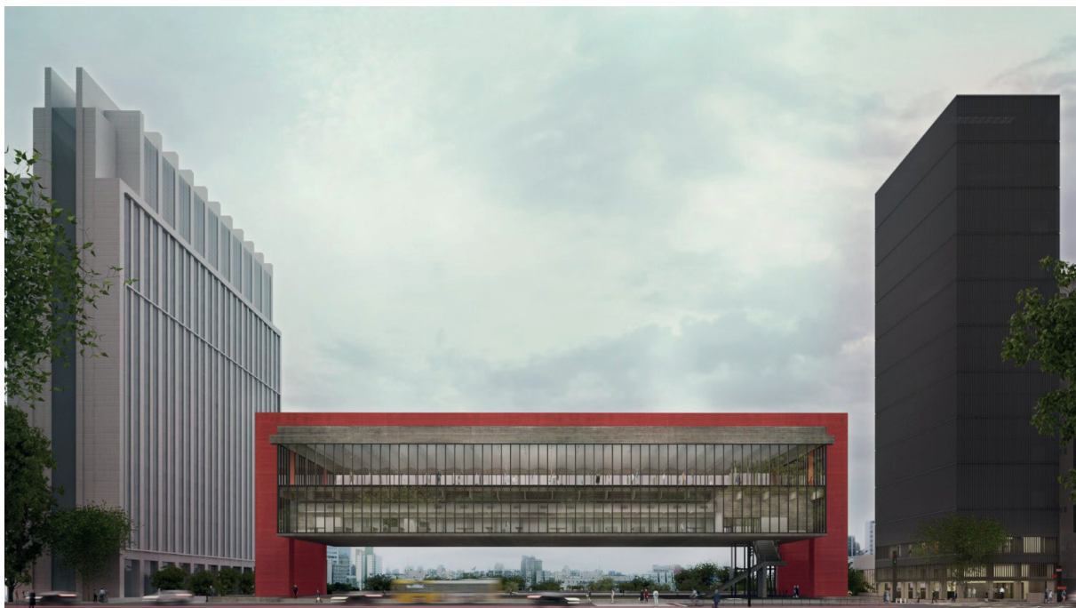
Figura 12 - MASP em expansão. Vista aérea frontal. Previsão: 2024.
