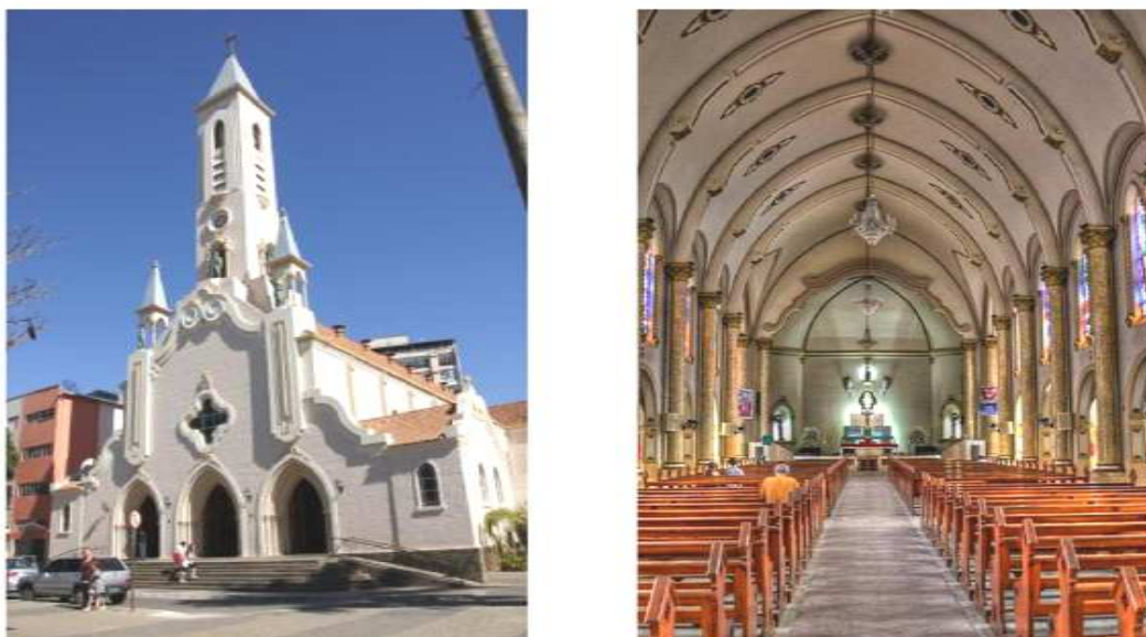
Figura 46: Atual igreja Matriz de Santa Rita de Cássia. Construída entre 1955 - 1960, eclética – de torre central. Viçosa/MG. Fotos: Elza Vieira - Agosto/2023.
