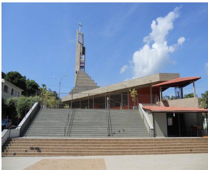
Figura 109: Vista da fachada frontal da igreja Matriz de Santo Antônio de Pádua construída em 1966. Modernista – Projetada por Flavio Almada. Astolfo Dutra/MG. Foto: Elza Vieira - Agosto/2023.
