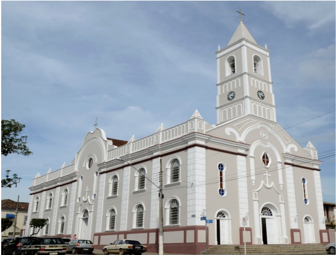
Figura 76: Igreja Matriz de São Manoel. Vista da fachada frontal e lateral esquerda. Rio Pomba/MG. Foto: Elza Vieira – Novembro/2023.
