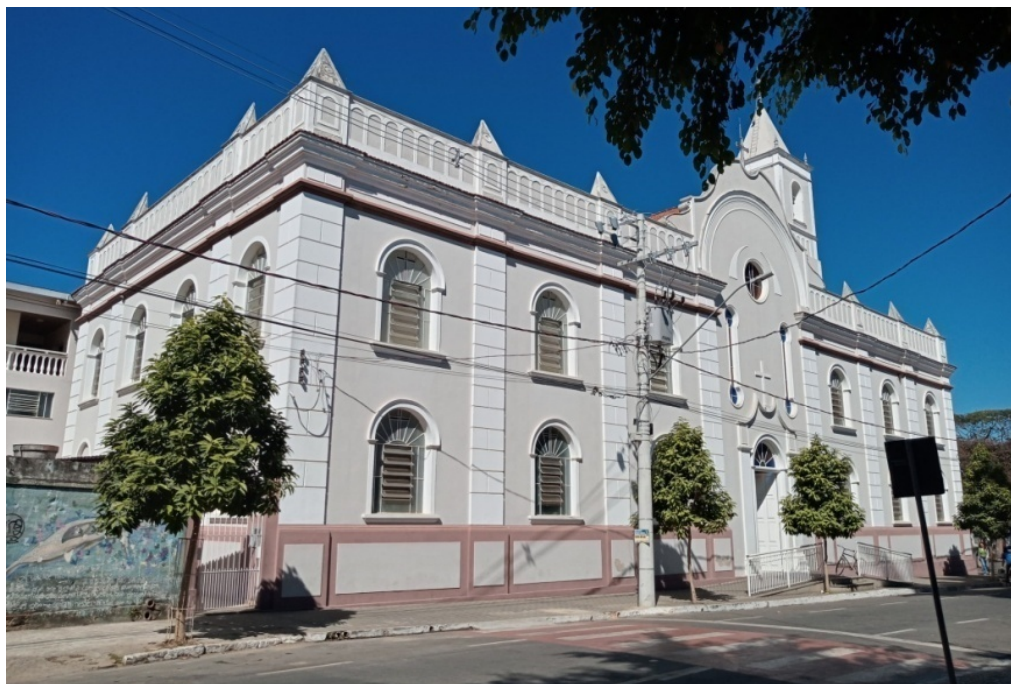
Figura 77: Igreja Matriz de São Manoel. Vista da fachada lateral esquerda e posterior. Rio Pomba/MG. Foto: Elza Vieira – Novembro/2023.
