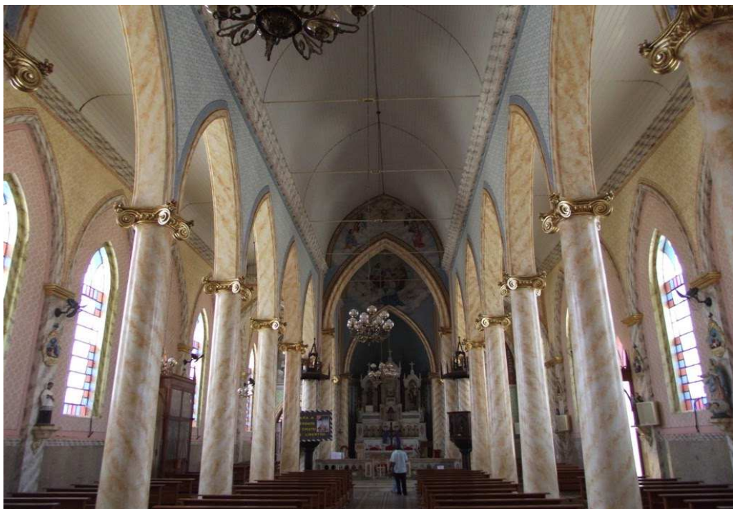
Figura 103: Vista do interior da Igreja Matriz de N.ª. S.ª das Mercês, construída em 1914 – 1925. Eclética/Neogótica. Mercês/MG. Foto: Elza Vieira - Julho/2023.
