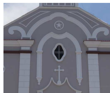
Figura 81: Igreja Matriz de São Manoel. Foto fachada frontal – detalhe central: óculo. Rio Pomba/MG. Foto: Elza Vieira - Dezembro/2023.
