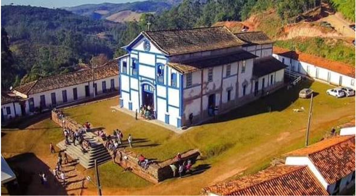
Figura 26: Igreja do Santuário do Bom Jesus de Bacalhau. Vistas da fachada frontal, lateral esquerda. Distrito de Santo Antônio do Pirapetinga, Piranga/MG. Fonte: < https://www.facebook.com/bomjesusdobacalhau/photos >.
