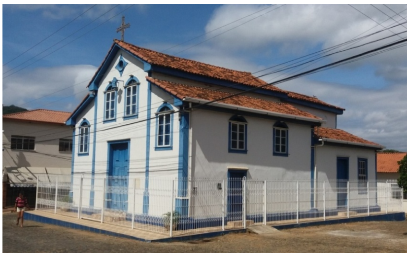
Figura 24: Igreja de Nossa Senhora do Rosário. Vista da fachada frontal e lateral direita. Descoberto/MG. Foto: Elza Vieira - Julho/2023.
