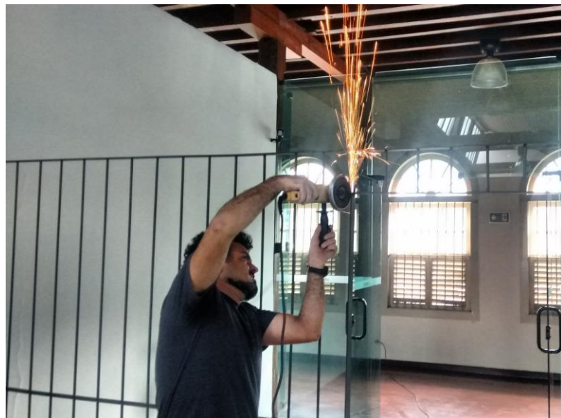
Figura 2 – Pequeno reparo na instalação “Um Lugar em Outro Lugar” (2016).
