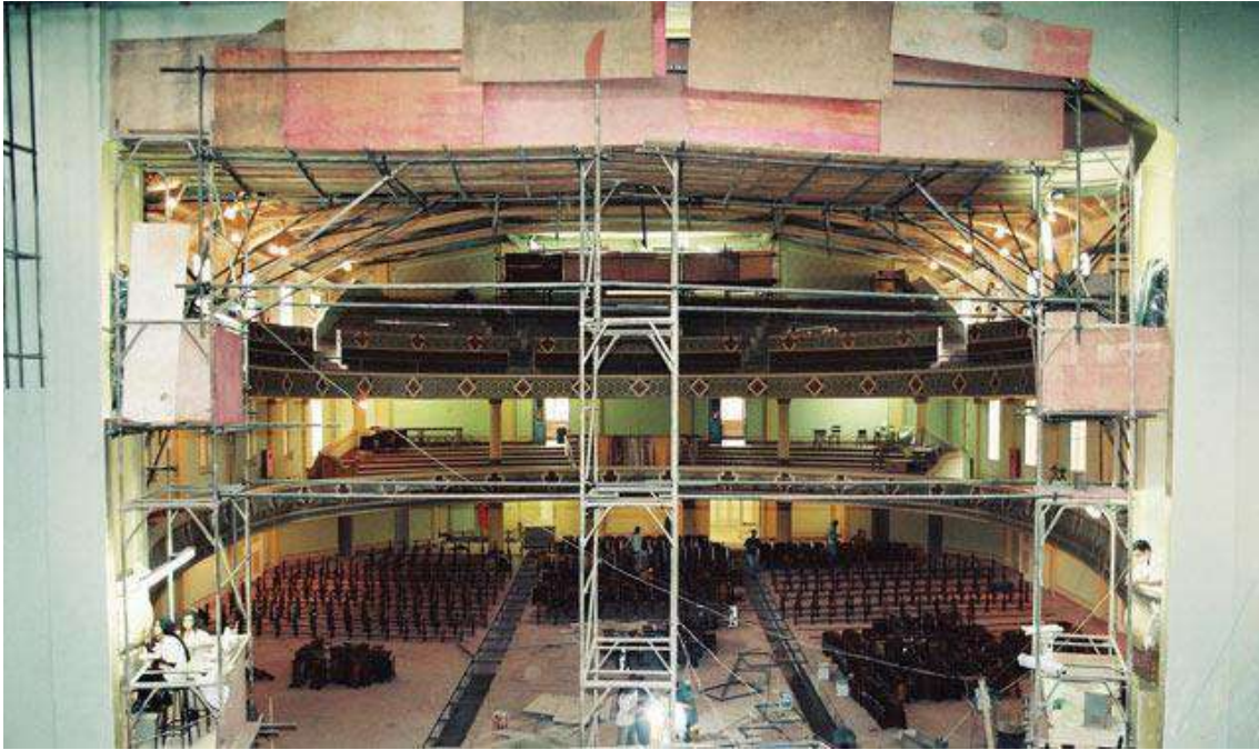
11.29. Plateia do central, restauração de 1996. Fonte: Groia, Franco. “ Reforma do Cine Theatro Central ”. 2010. Acesso 23 abr. 2022.
