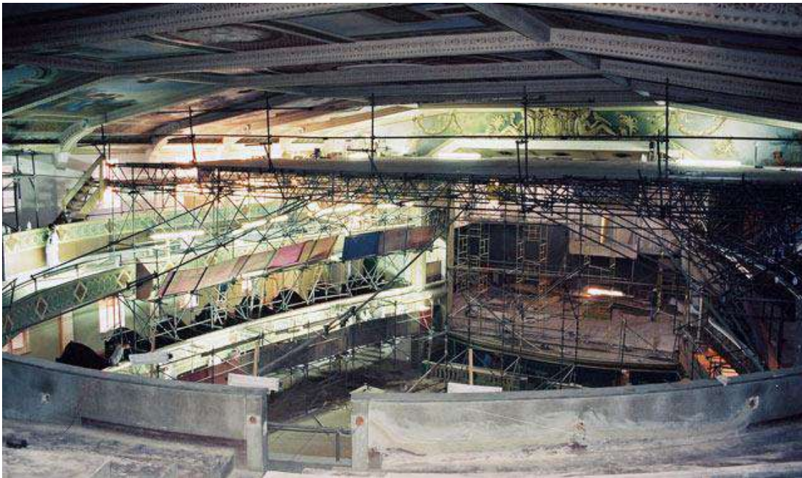
11.28. Camarotes e palco do Central, em reforma, restauração de 1996. Fonte: Groia, Franco. “ Reforma do Cine Theatro Central ”. 2010. Acesso 23 abr. 2022.
