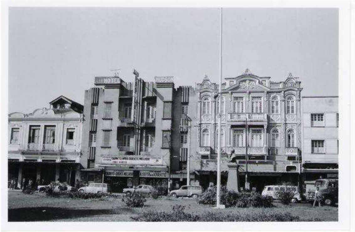
22.10. Fachada do São Luiz em 1977. Fonte: Site “ Maurício Resgatando o Passado ”. Acesso 03 abr. 2022.
