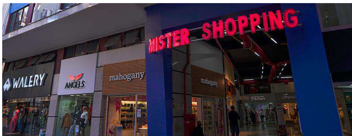
2.2. Fachada do Mister Shopping (não foram encontradas fotos do Cine Star). Fonte: Facebook do Mister Shopping . Acesso em 05 abr. 2022.
