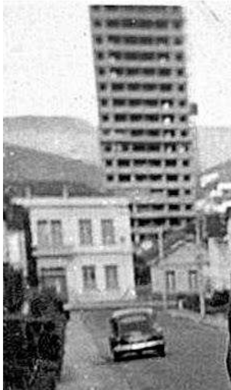
24.3. Cine Excelsior em construção visto da rua Oswaldo Cruz, 1957. Fonte: Site " Maria do Resguardo ". Acesso 03 abr. 2022.
