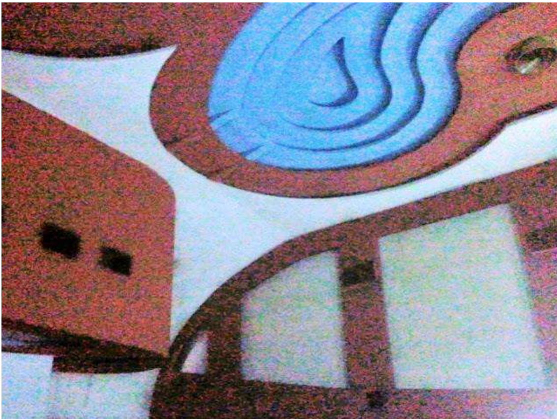
24. 18. Detalhe do teto Excelsior em 2011. Fonte: Site “ Maria do Resguardo ”. Acesso 03 abr. 2022.
