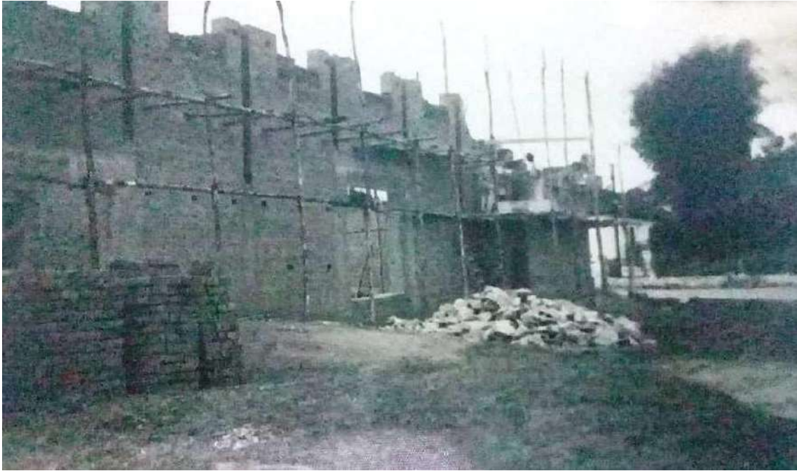
25.7. Cine Benfica em construção, lateral. Fonte: Site “ Maurício Resgatando o Passado ”. Acesso 04 abr. 2022.
