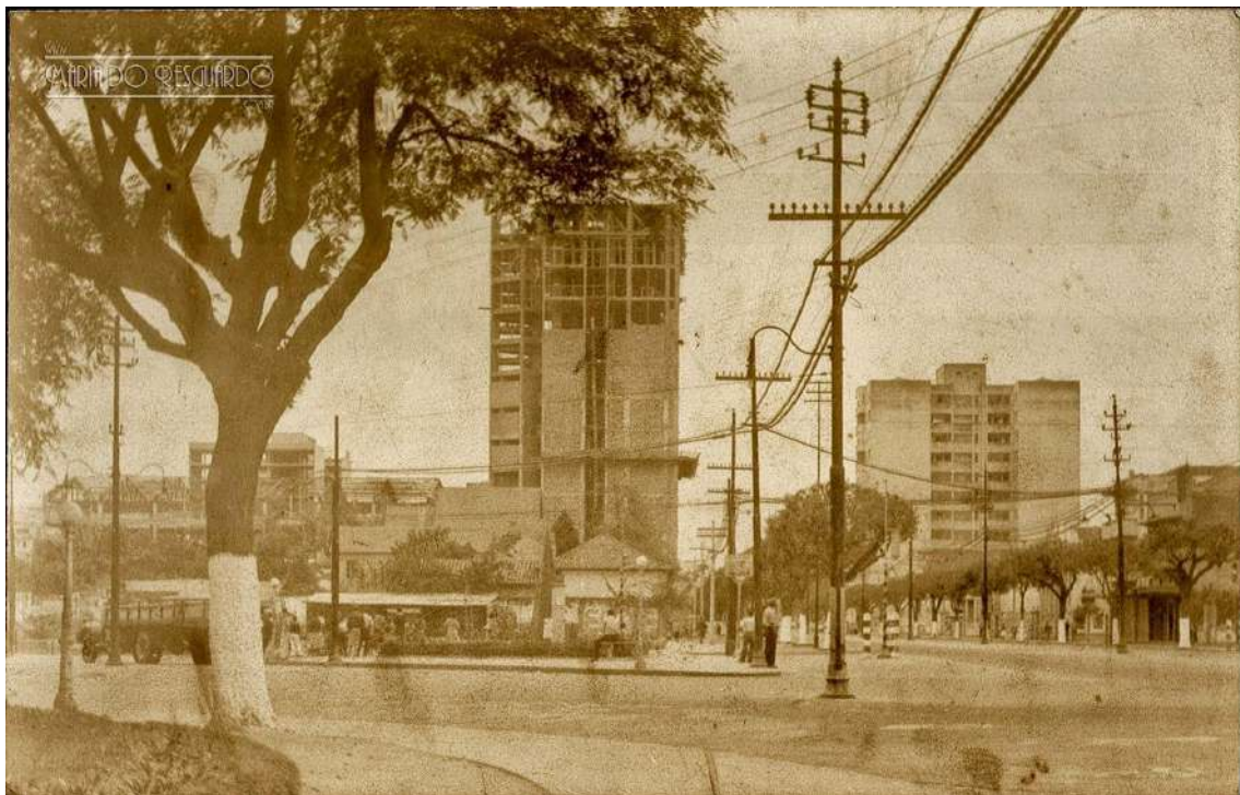
24.2. Cine Excelsior em construção visto da Av. Barão do Rio branco. Fonte: Site " Maria do Resguardo ". Acesso 03 abr. 2022.
