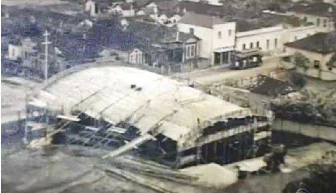
20.5. Construção do Cine Paraíso em 1952 ou 1953. Fonte: Site “ Maurício Resgatando o Passado ”. Acesso 03 abr. 2022.
