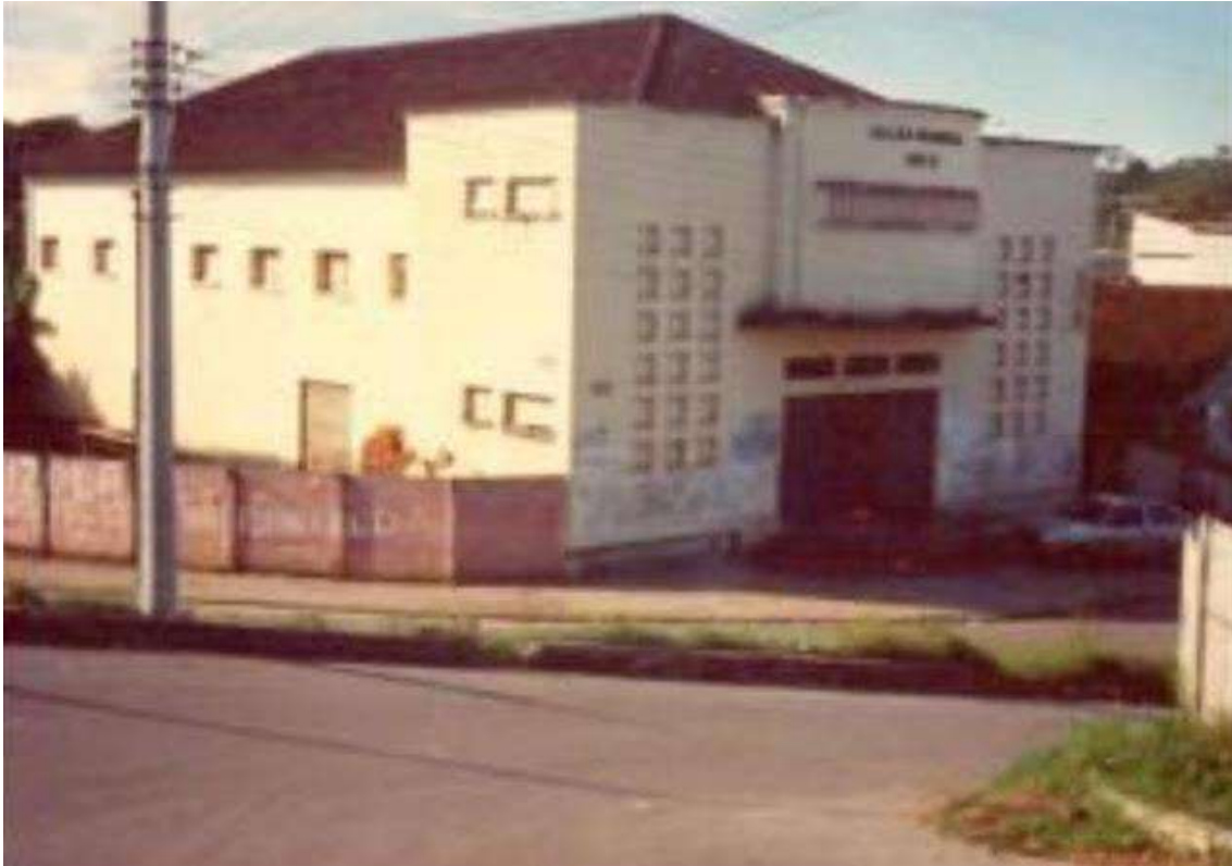
25.5. Vista lateral do Centro Cultural Benfica na década de 1990. Fonte: Site “ Maurício Resgatando o Passado ”. Acesso 04 abr. 2022.
