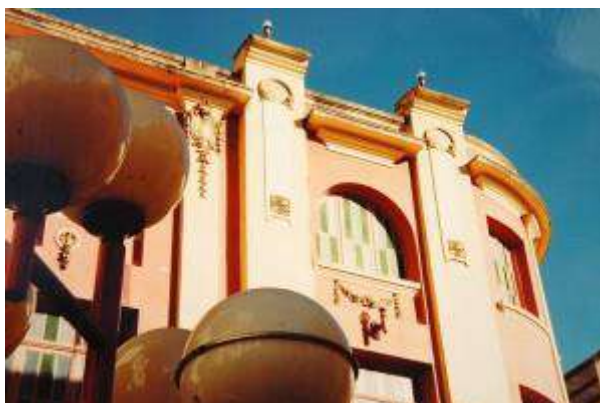
11.33. Detalhe da fachada do Central, 2014~2018. Fonte: Cine – Theatro Central/Alexandre Dornelas . Acesso 23 abr. 2022.
