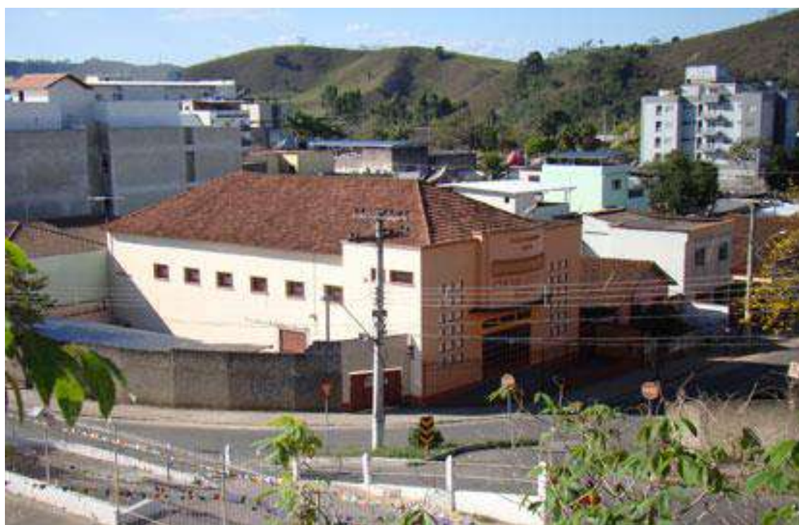
25.4. Vista lateral do Centro Cultural Benfica em 2010. Fonte: site “ Benfica Net ”, acesso 04 abr. 2022.
