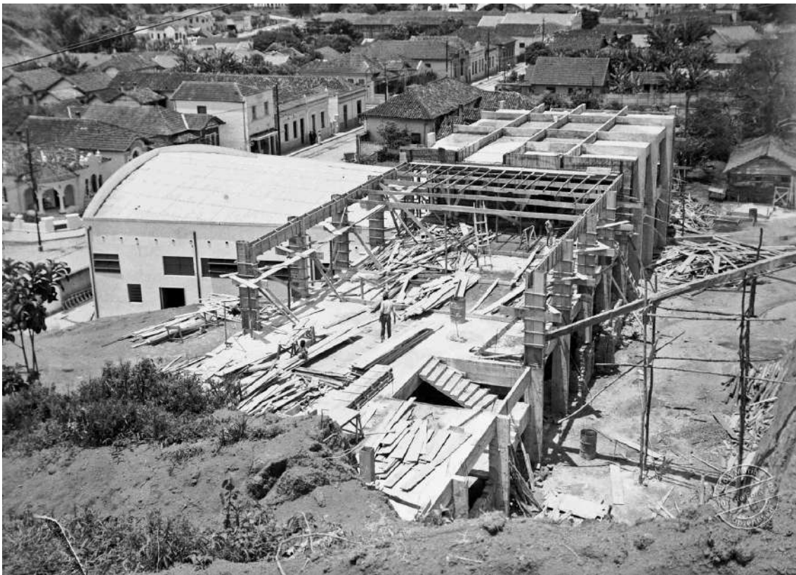
20.4. Construção do Cine Paraíso e do Instituto Maria em 1952 ou 1953 visto de outro ângulo. Fonte: Site “ Maria do Resguardo ”. Acesso 03 abr. 2022.
