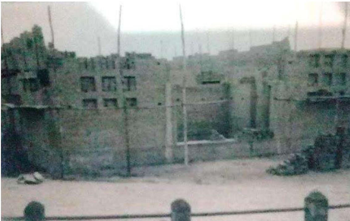
25.6. Cine Benfica (talvez aqui apenas Paróquia Pio XI) em construção, fachada, talvez na década de 1940. Fonte: Site “ Maurício Resgatando o Passado ”. Acesso 04 abr. 2022.
