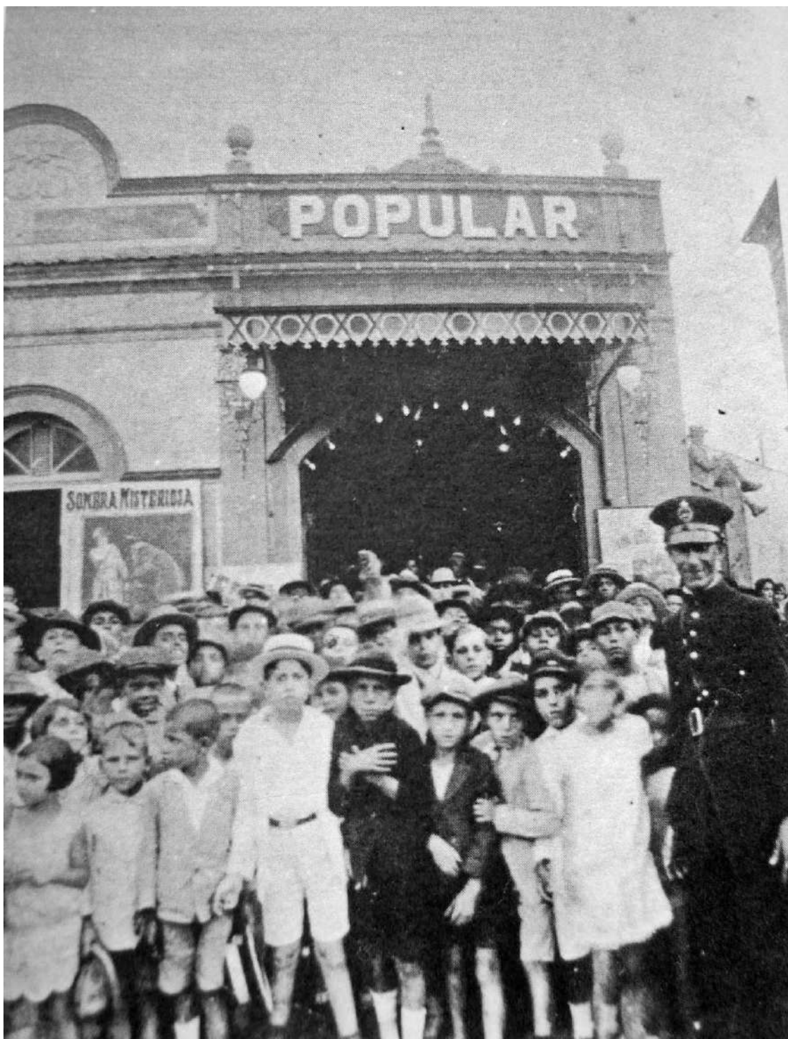
9.1. Público saindo do Cine Popular e sua fachada, na inauguração, em 14 de agosto de 1927. Fonte: site " Maria do Resguardo ". Acesso 02 abr. 2022.
