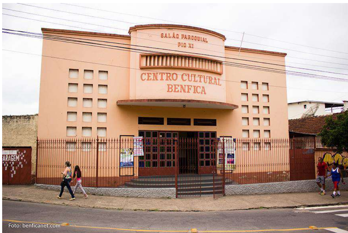
25.3. Centro Cultural Benfica em 2015. Fonte: site “ Benfica Net ”, acesso 04 abr. 2022.
