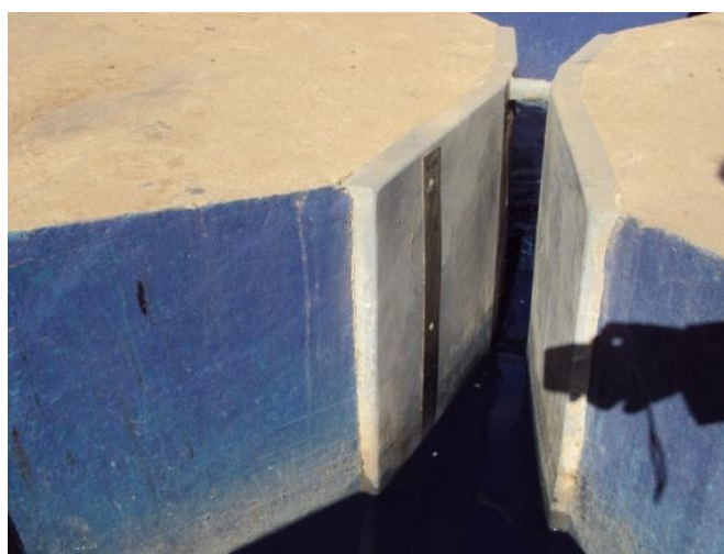
Figura 5: Calha Parshall – WashBrasil.
