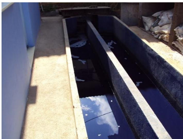
Figura 4: Caixa de Retenção de Areia – WashBrasil.
