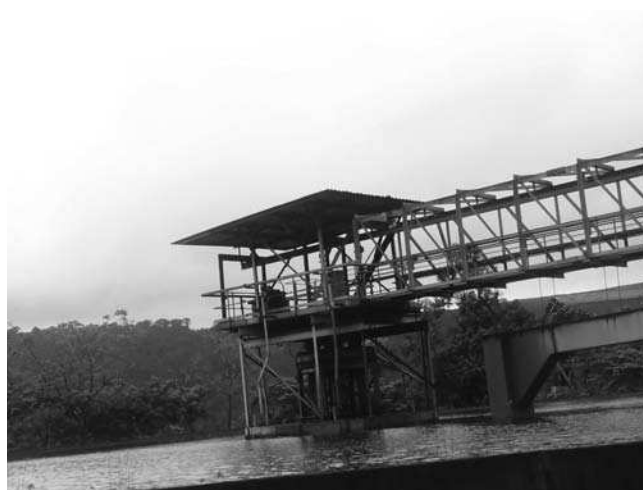
Fotos 19 a 21: mina de Carajás
