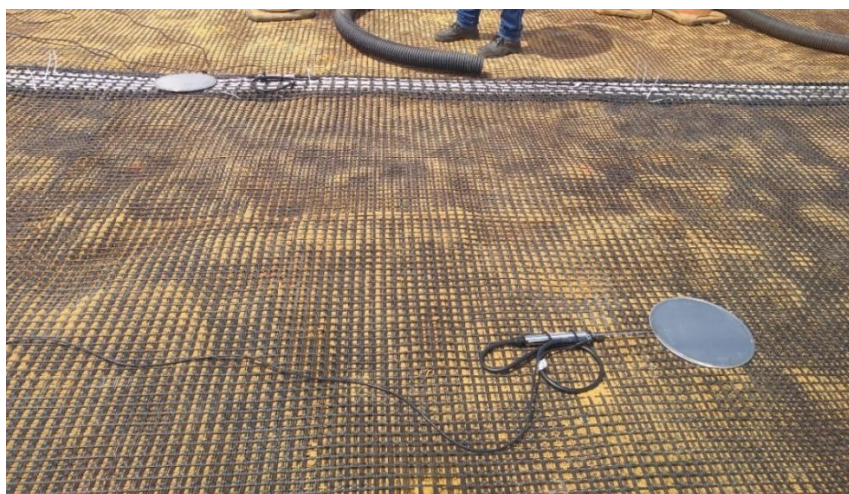
Figura 29 - Células de tensão total instaladas sobre geogrelha.
