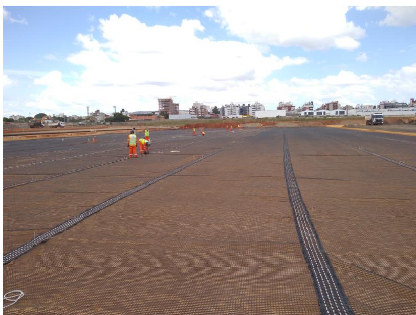
Figura 34 – Instalação da geogrelha.
