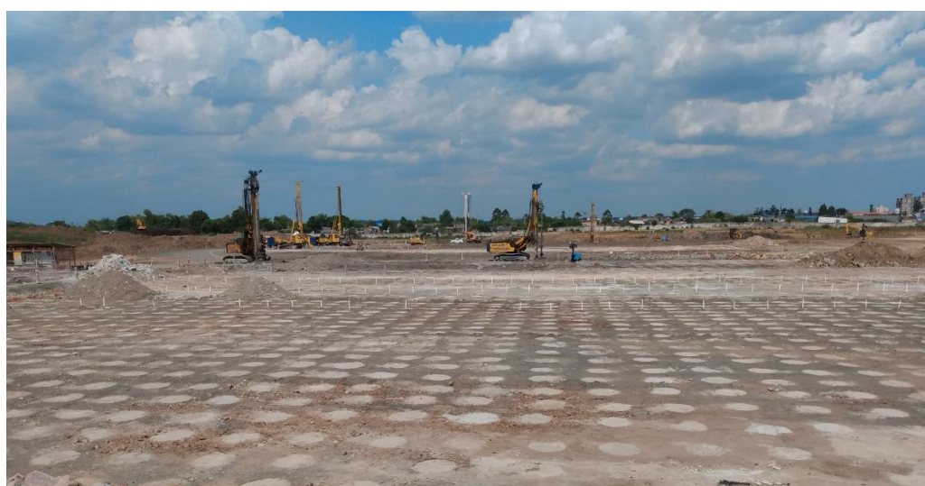
Figura 41 - Malha de colunas DSM.
