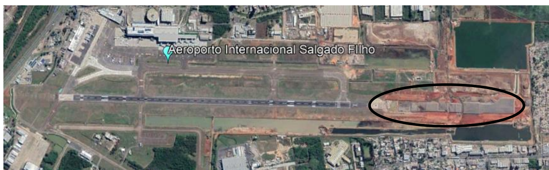
Figura 5.1 - Imagem de satélite do local da obra.
