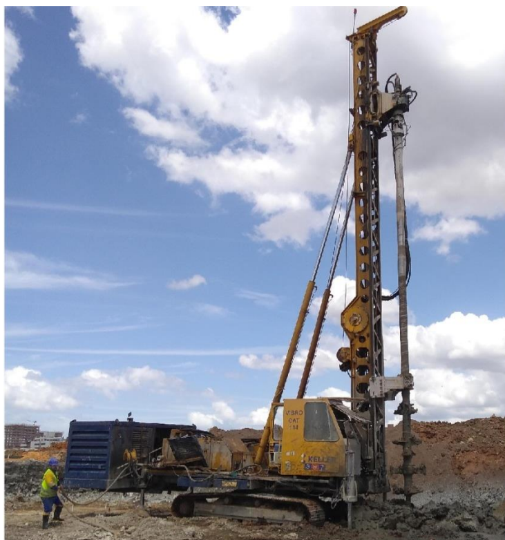
Figura 4.6 – Equipamento de perfuração do solo e injeção da calda com um eixo.
