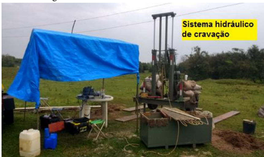
Figura 5.10 - Ensaio CPTU 58 em andamento.
