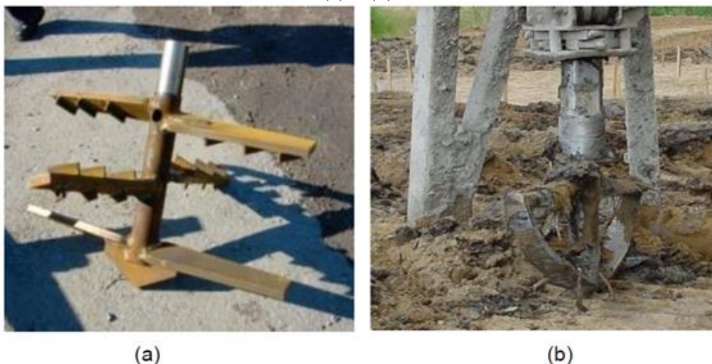
Figura 4.2 - Tipos de ferramenta usados no método seco de mistura profunda do solo - (a) e (b).
