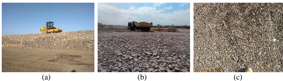
Figura 5.7: Execução do aterro de rachão (a); vista superior do aterro de rachão (b) e camada executada de BGS (c).
