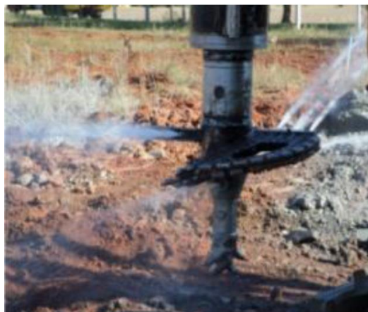
Figura 4.9: Eixo misturador com alguns orifícios de injeção abertos, indicando sua posição na ponta da ferramenta.
