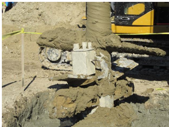
Figura 4.18 - Equipamento para execução de colunas DSM com caixa para retirada de amostras de solo e ligante.
