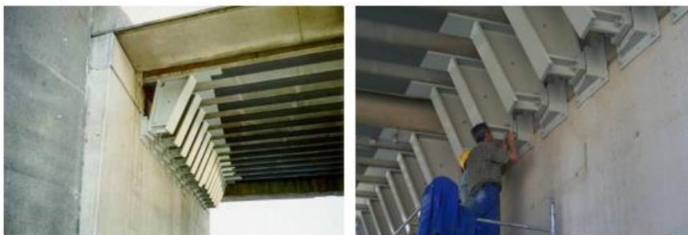
Figura 13 – Detalhes do procedimento de reforço e dos mancais
