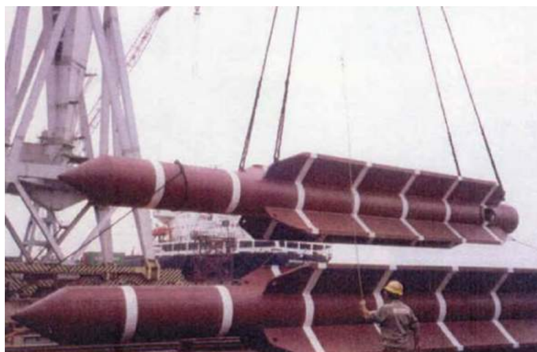
Figura 43 – Exemplo de Estaca Torpedo
