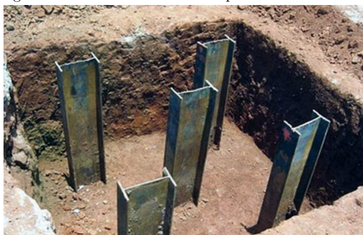
Figura 3 – Estacas metálicas em perfil cravadas no solo
