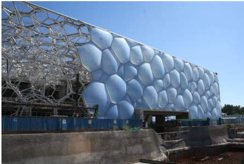
Figura 17 – Edifício Cubo D'água em Pequim, durante construção
