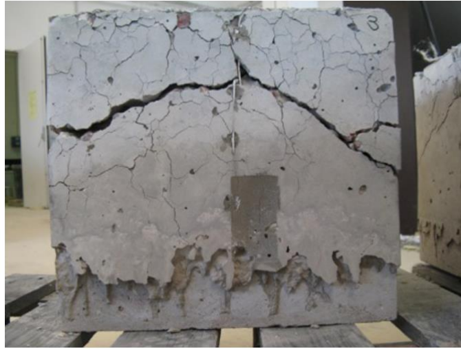
Figura 5 - Efeito de spalling visível.
