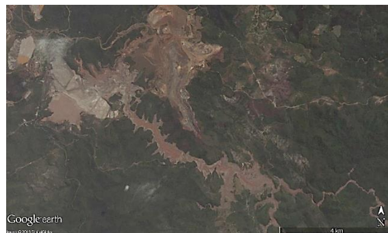
Figura 2: Complexo das barragens de Fundão/Santarém/Germano, e a localidade de Bento Rodrigues, em novembro de 2015, após o rompimento de Fundão.
