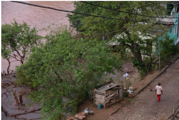
Foto 55: Detalhe das edificações atingidas pela lama nas margens do rio Doce.
