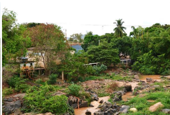
Foto 18: Detalhe dos encanamentos utilizados para a captação de água no rio Guandu.
