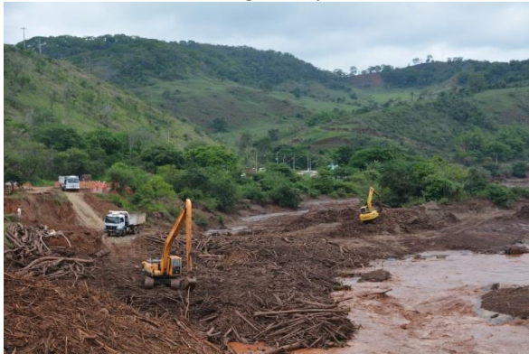
Foto 41: Detalhe dos tratores retirando os troncos das margens da represa Risoleta Neves.
