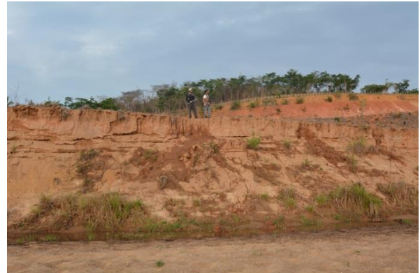
Foto 12: Depósitos fluviais em trecho de forte assoreamento.
