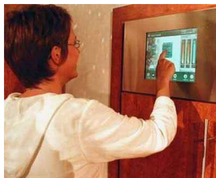
Figura 44: Painel de controle de um Sistema Domótico
