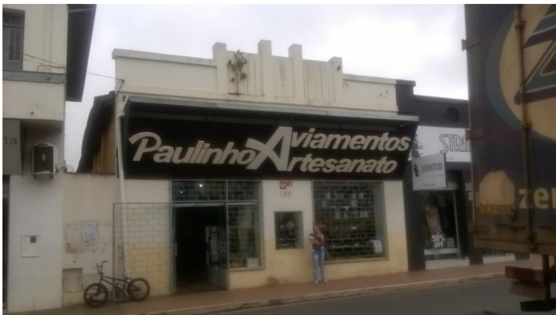
Prédio onde foi o Cine-Theatro Glória, posteriormente Móveis Carvalho. Fonte: Tirada pela autora em janeiro de 2018.
