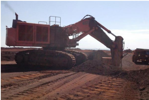
Figura 5 - Remoção de material do solo.
