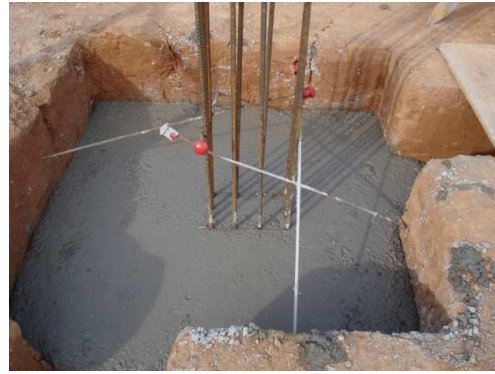
(b) Bloco de coroamento concretado – Cortesia do Prof. Pedro Kopschitz
