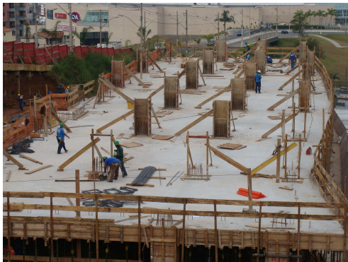
(a) Laje maciça de uma edificação – Cortesia do Prof. Pedro Kopschitz
