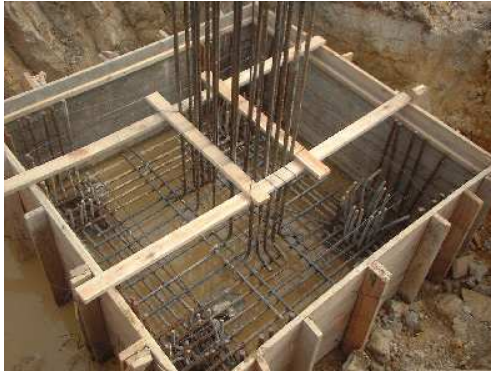
(a) Forma e armação de um bloco de coroamento
