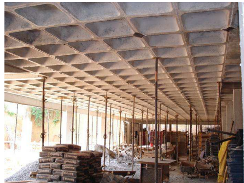
(b) Laje nervurada de uma edificação – Cortesia do Prof. Pedro Kopschitz
