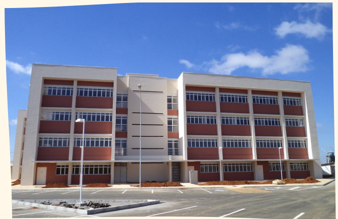
Bloco C do prédio novo quase finalizado. Foto: Confiança Alumínio e Vidro
