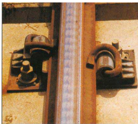
Figura 13 – Corrugação claramente visível
