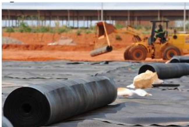
Figura 13 - Instalação da manta de impermeabilização no Aterro de Brasília.
