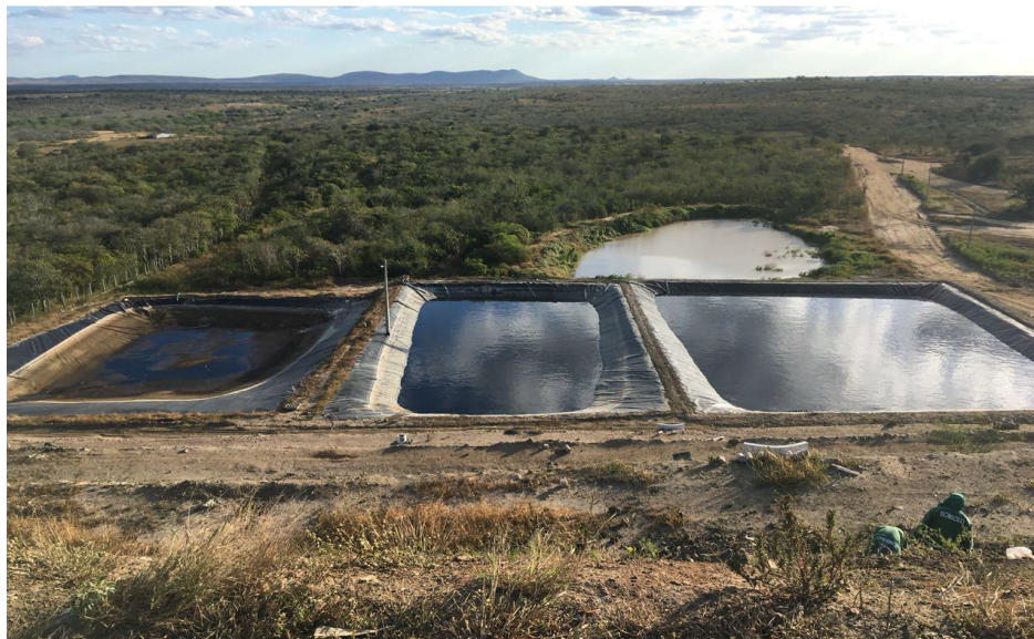
Figura 16 - Lagoas de Estabilização do Aterro Sanitário de Campina Grande – PB.
