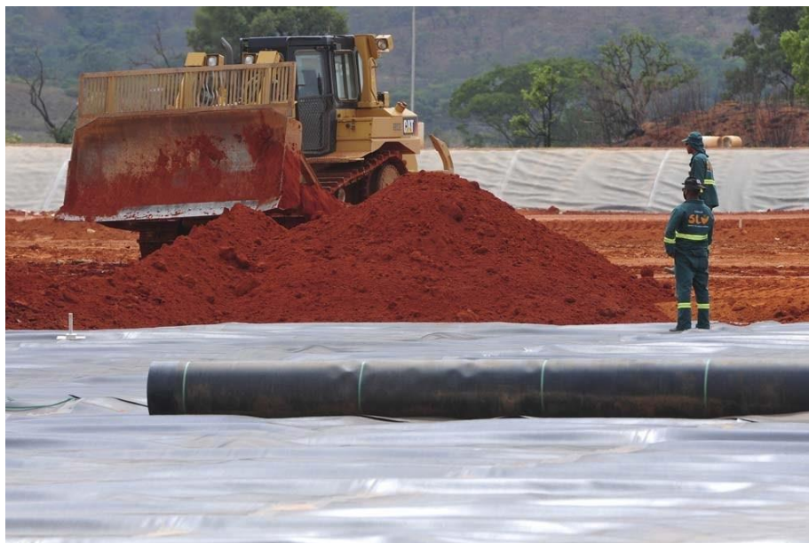
Figura 14 - Disposição de solo argiloso compactado e posteriormente a manta impermeabilizante no Aterro de Brasília (2017).
