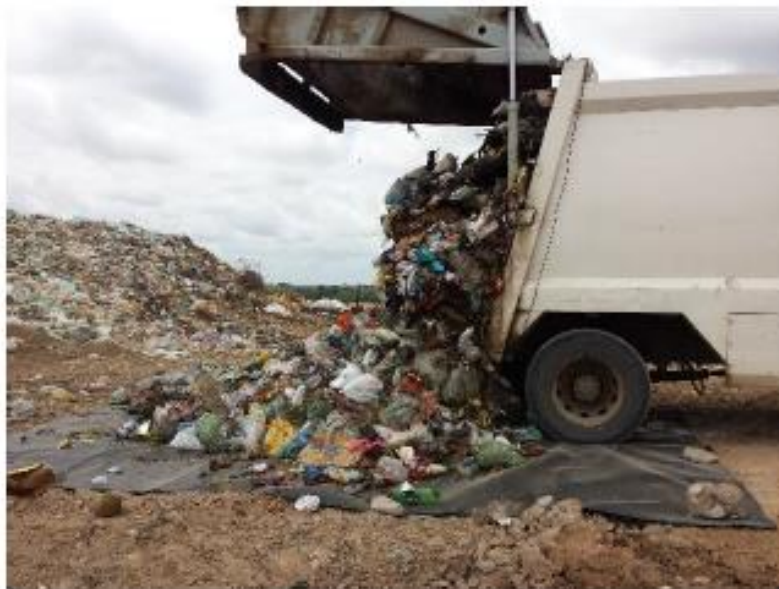
Figura 5 - Descarregamento dos RSU pelo caminhão compactador ou caçamba numa área pré-determinada e protegida com lona PEAD.
