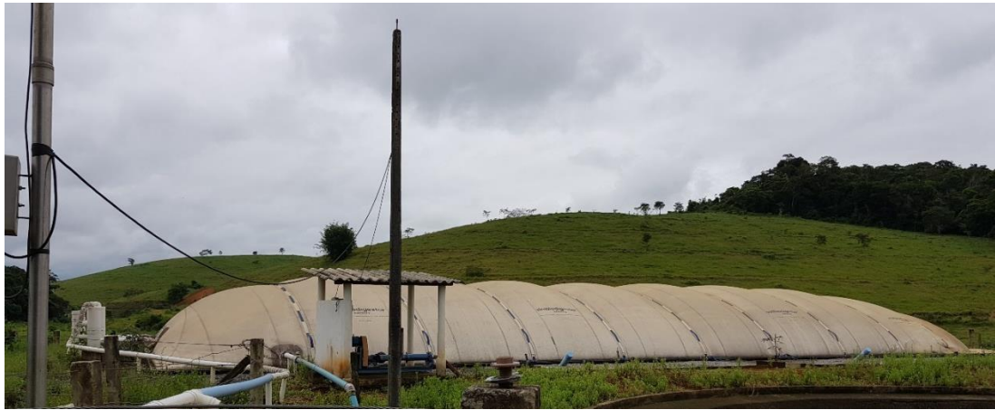
Figura 3.1- Foto do biodigestor modelo canadense alocado na Fazenda Experimental da Embrapa em Coronel Pacheco.
