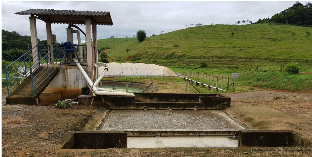
Figura 4.5- Foto de parte do sistema de tratamento: biodigestor (ao fundo) e lagoa de armazenamento (à frente).
