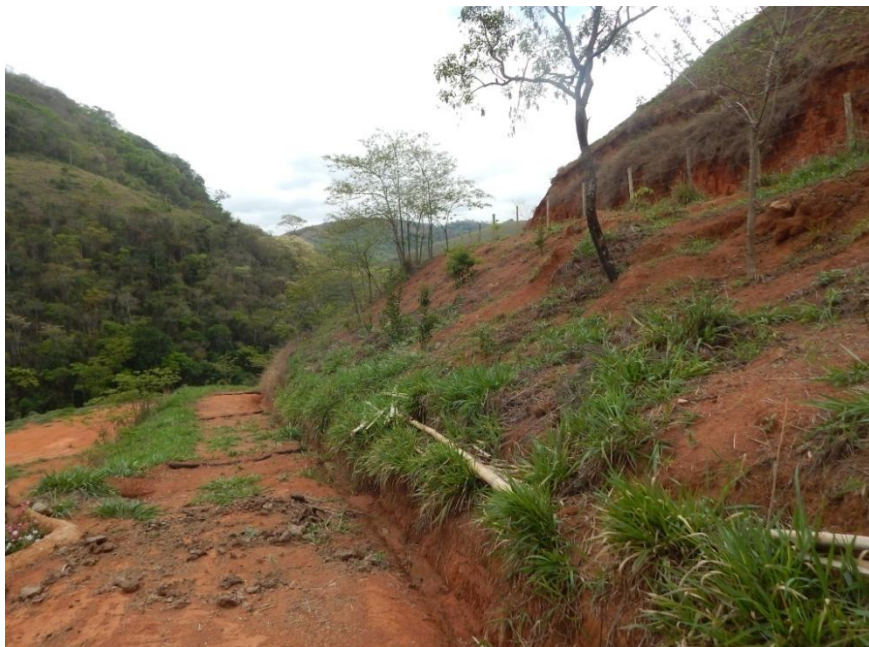
Figura 12: Estrada não pavimentada, trecho 4. Fonte: Acervo do autor.
