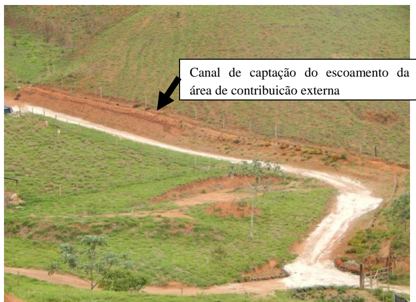
Figura 9: Estrada não pavimentada, trecho 1 Fonte: Acervo do autor.
