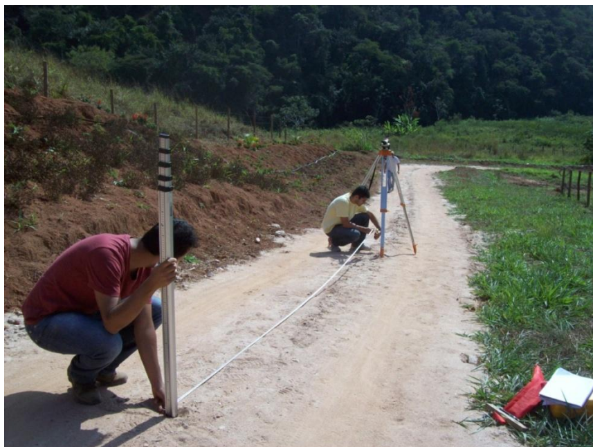
Figura 23: Medição da distância horizontal entre os pontos. Fonte: Acervo do autor.
