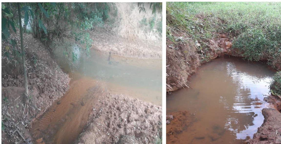
Figura 21 Deposição de sedimentos no Córrego da Pindaíba
