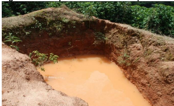
Figura 24 Exemplo de caixa de retenção
