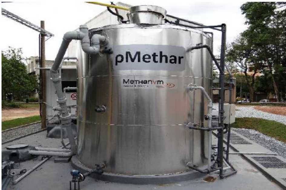
Figura 1 – Reator de metanização de câmara única de resíduos orgânicos da UFMG.
