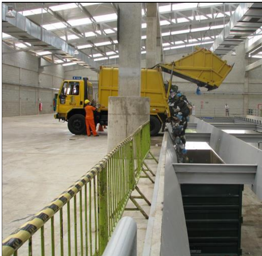
Foto 5 - Estação de transbordo – realizada direto no veículo transportador.
