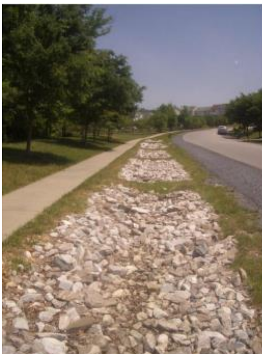
Figura 8 — Trincheira de infiltração.
