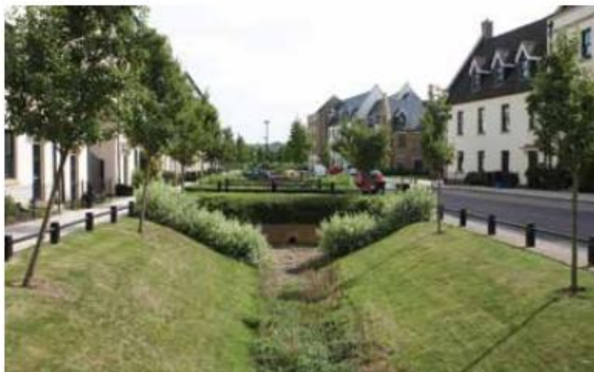
Figura 14 — Vala revestida por cobertura vegetal integrada à zona urbana.
