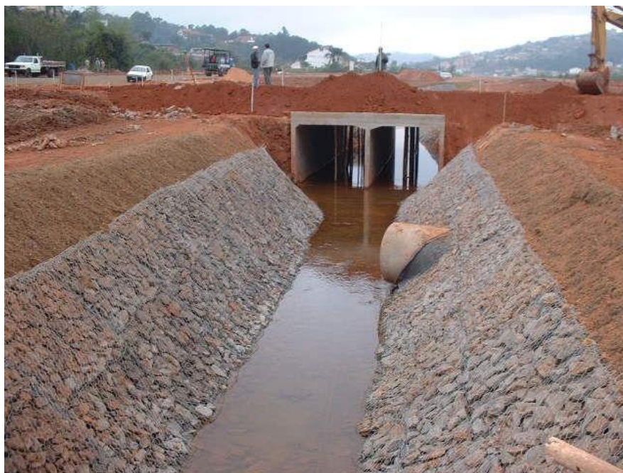
Figura 25 — Canalização do córrego no trecho entre o German e a Represa São Pedro.
