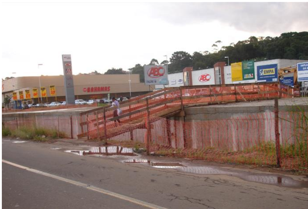
Figura 24 — Altura do canal construído para a canalização do Córrego São Pedro.
