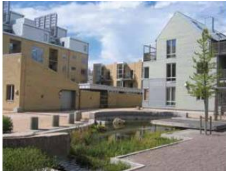
Figura 21 — Wetland construída em área urbana.
