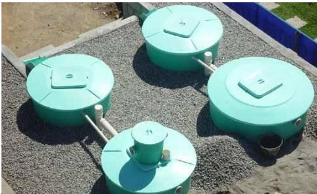
Figura 13: Sistema experimental fossa-filtro do CESA/UFRJ (Fonte: Silva, 2012)
