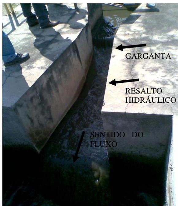
Figura 05: Medidor de vazão: calha Parshall– ETE Teresina, AGESIPA. (Fonte: Santos, 2012).
