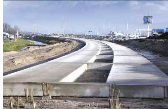
Figura 3 – Utilização de concreto na superestrutura ferroviária.
