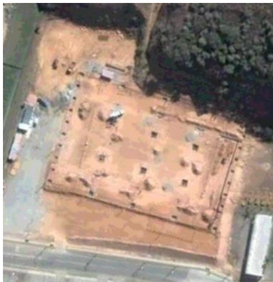
FIGURA 24: INÍCIO DA OBRA FONTE: GOOGLE EARTHE
