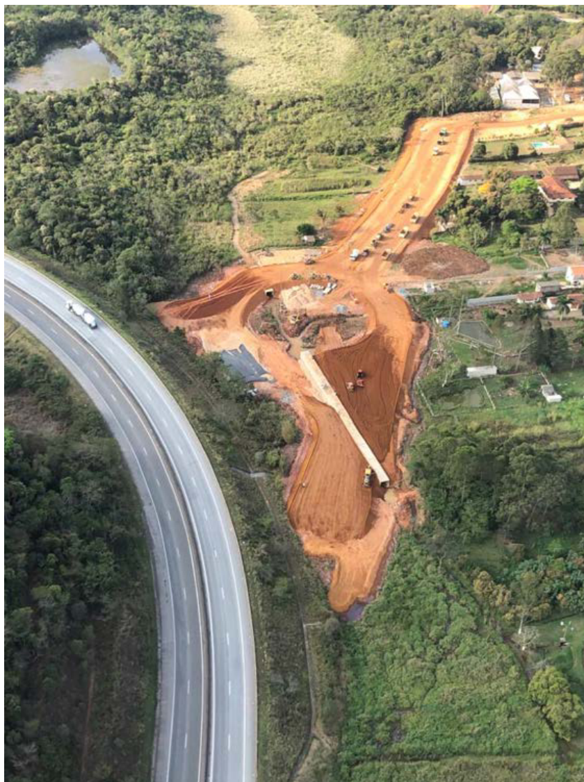
Figura 4 – Intersecção da BR-440 com BR-040, com canalização do córrego Grota do Pinto.
