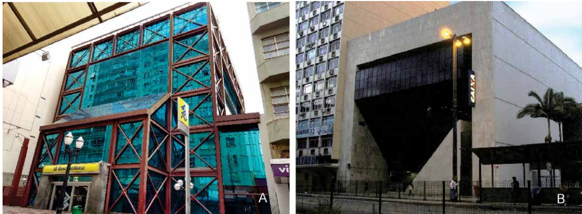
Figura 2.7 | (A) BB – é praticamente um cubo e a única estrutura de aço no calçadão da Rua Halfeld; (B) CEF – é um paralelepípedo com uma geometria de fachada que tem a geração de uma estrutura piramidal invertida retirada de sua volumetria, criando-se um espaço de transição coberto entre a rua e o interior da agência na Av. Barão do Rio Branco. Fonte: Fotos dos autores, 2018.
