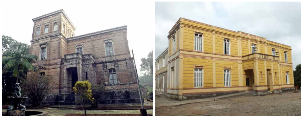
Figura 4.1 | Museu Mariano Procópio, Fachada da Villa (à esquerda) e do edifício Mariano Procópio (à direita).
