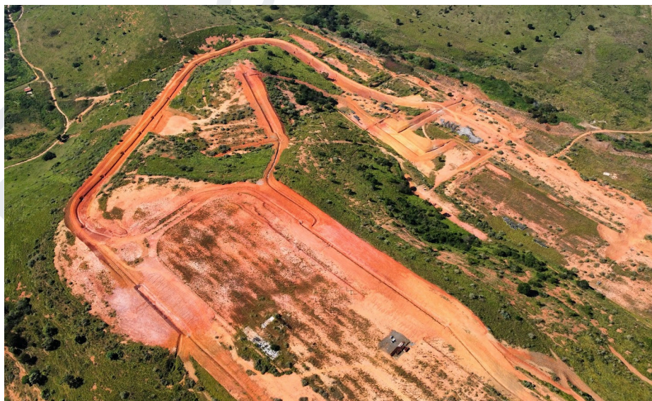
Imagem 17 - Terreno do Campus GV em maio de 2024
