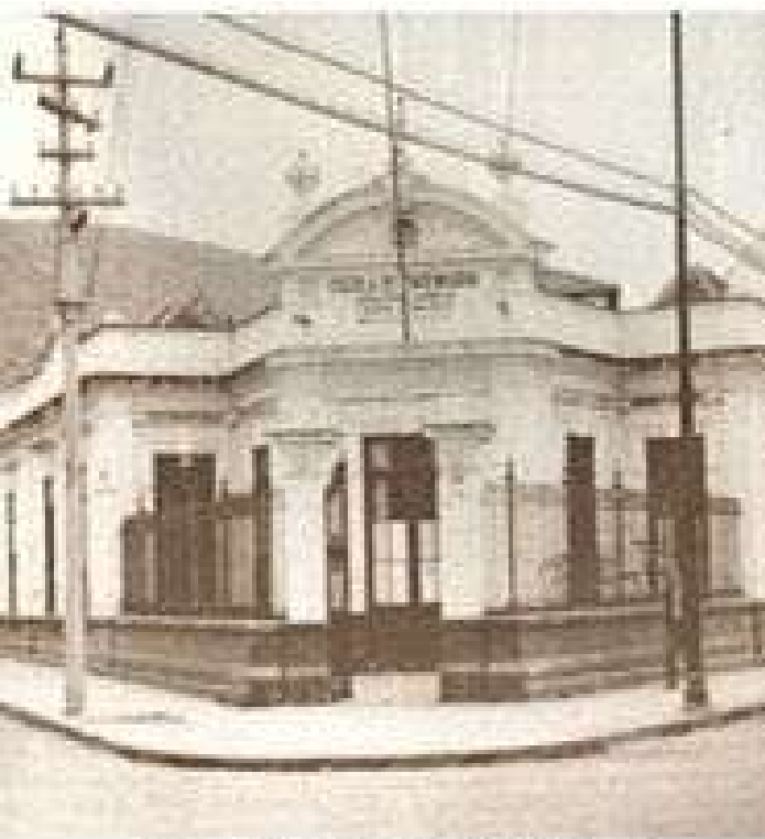
Arquiteto: Antônio de Aguiar. Construção do Colégio de Engenharia.
