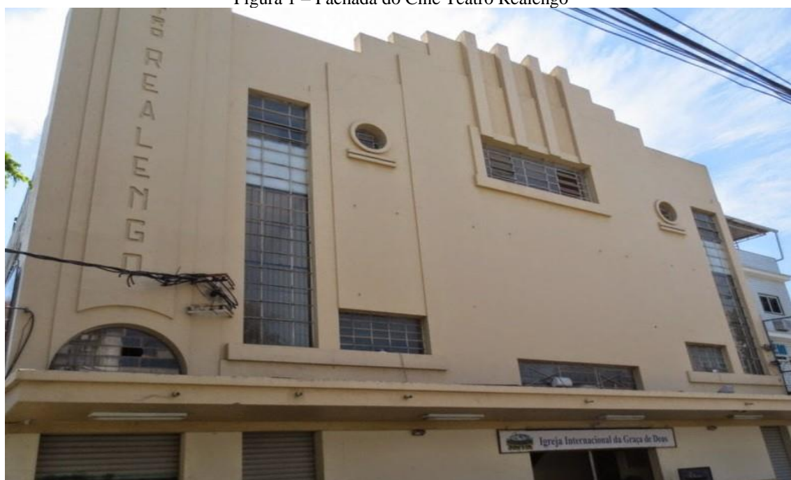
Figura 1 – Fachada do Cine Teatro Realengo
