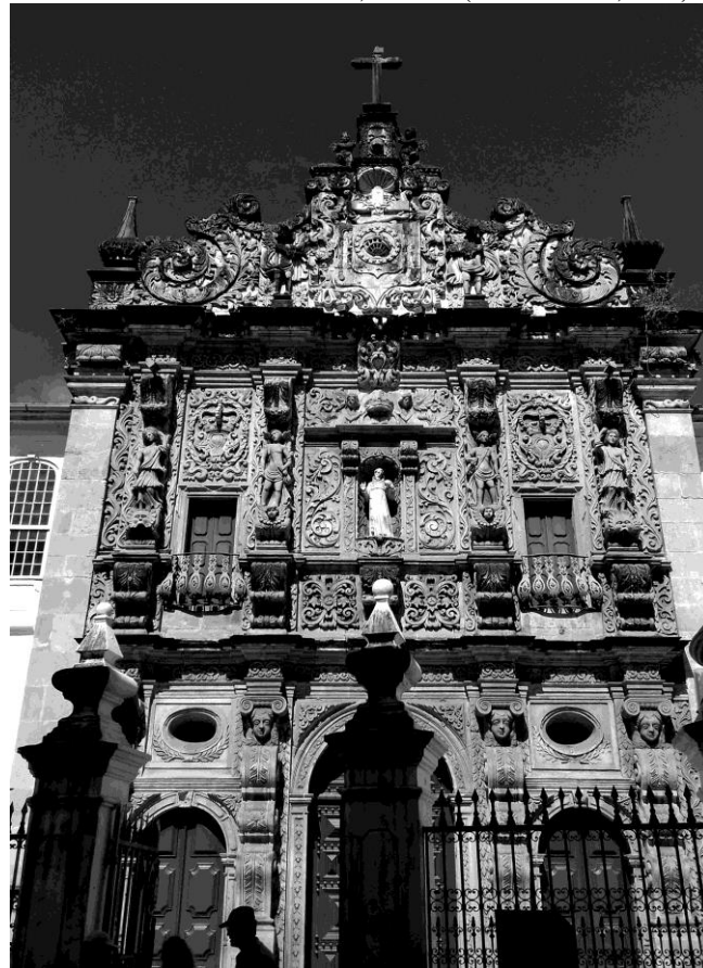
Figura 5 – Fachada da igreja (foto da autora, 2016)
