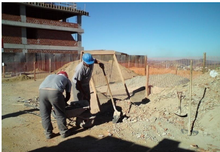
Figura 22 - Transporte Interno de resíduo com carrinho de mão para baía de acondicionamento.
