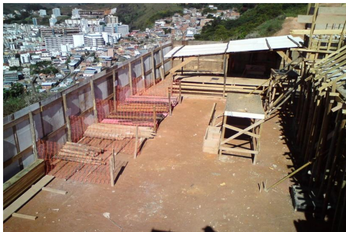
Figura 21 - Baías para acondicionamento de madeira a ser reutilizada na obra.
