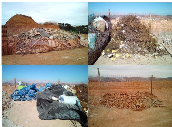
Figura 20 - Baias para acondicionamento de madeira, aço, plástico e tijolo.
