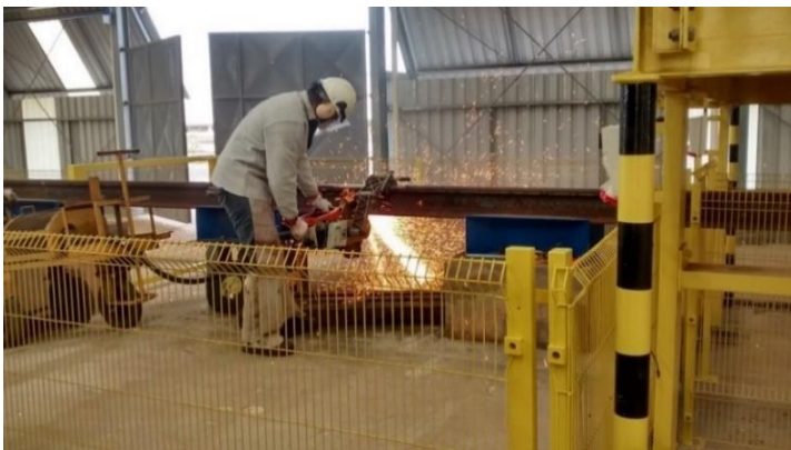
Figura 57: Procedimento de corte de trilhos por abrasão. Fonte: Próprio autor.
