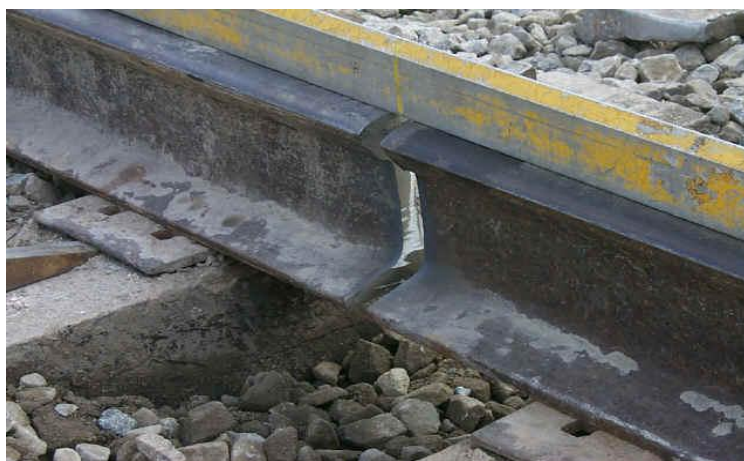
Figura 12: Alinhamento dos trilhos.
