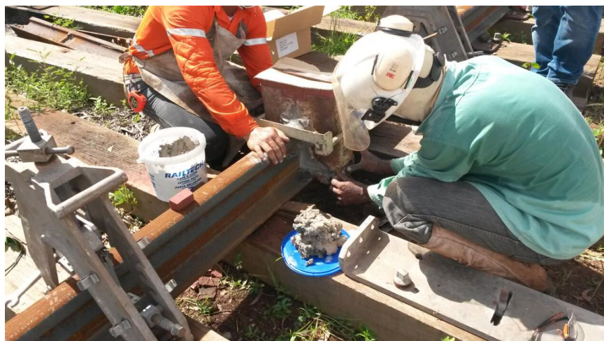
Figura 15: Vedação do molde com pasta refratária. Fonte: Equipe do projeto (EFC, 2016)
