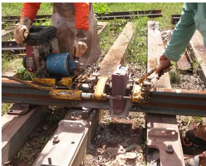
Figura 19: Corte do molde utilizando equipamento eletro-hidráulico. Fonte: Equipe do projeto (EFC, 2016).
