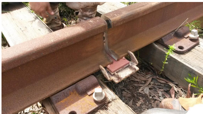
Figura 13: Molde do patim fixado. Fonte: Equipe do projeto (EFC, 2016)
