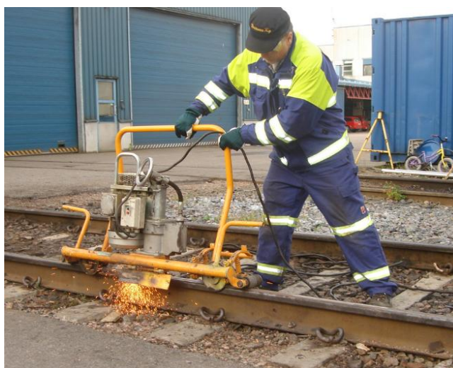
Figura 20: Tratamento superficial da solda utilizando-se esmerilhadora manual. Fonte: http://mankinen.fi/en/track-maintenance/rail-grinding/
