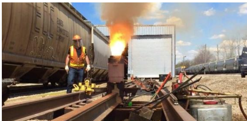
Figura 17: Reação aluminotérmica no interior do cadinho e preenchimento do molde. Fonte: https://media.licdn.com
