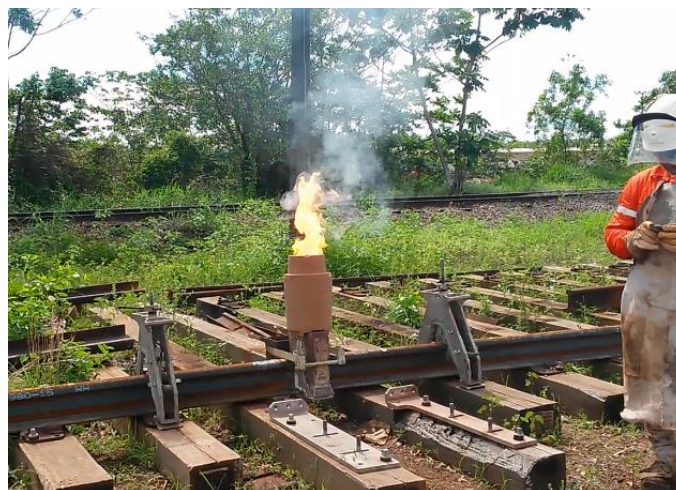
Figura 15: Mistura Thermit® pegando fogo dentro do cadinho montado acima do molde. Fonte: Equipe do Projeto.
