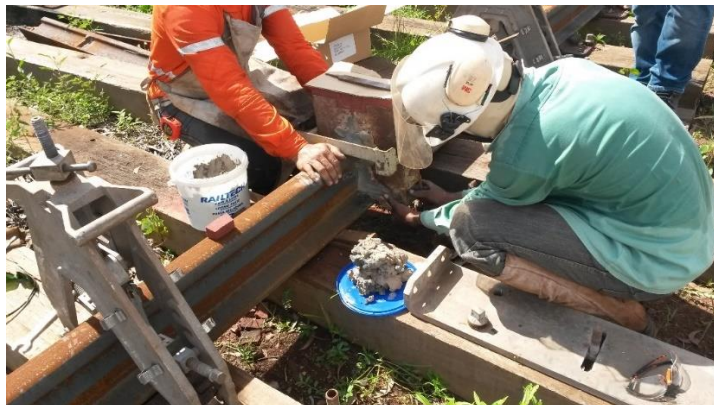
Figura 13: Vedação do molde com pasta refratária. Fonte: Equipe do projeto.
