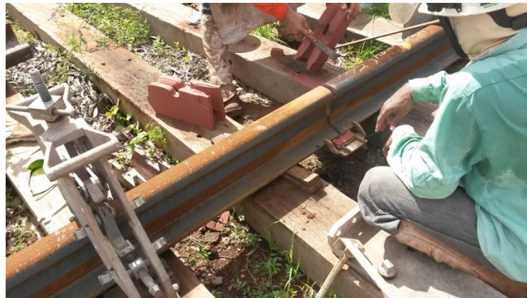
Figura 11: Parte inferior do molde fixada e lixamento das partes laterais para adaptação ao trilho. Fonte: Equipe do projeto.
