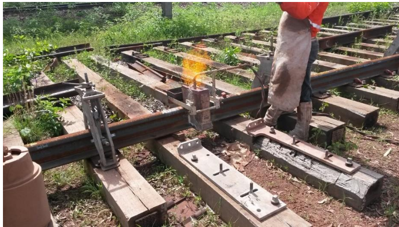
Figura 14: Sistema de apoio e maçarico aquecendo o interior do molde. Fonte: Equipe do projeto.
