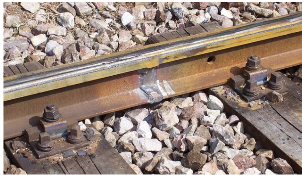
Figura 8: Imagem ilustrativa de trilhos unidos por solda.
