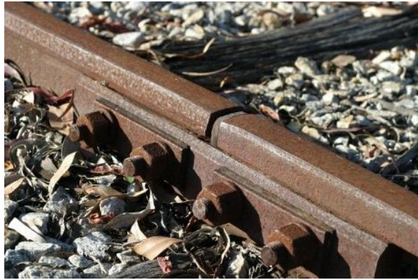
Figura 7: Imagem ilustrativa de trilhos unidos por tala de junção. Fonte: http://3.bp.blogspot.com/ . Acessado em: <09/07/2016>
