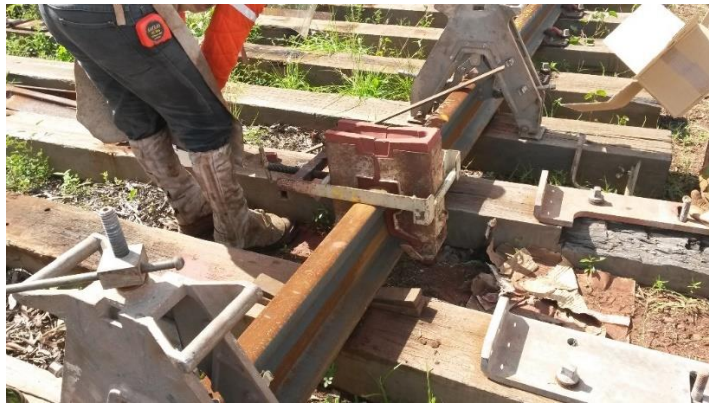
Figura 12: Molde montado e fixado por cinta metálica. Fonte: Equipe do projeto.
