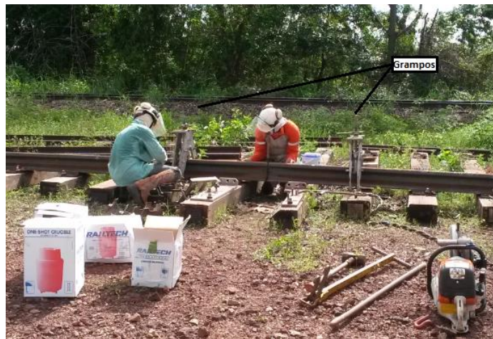
Figura 10: Grampeamento e alinhamento do trilho. Fonte: Equipe do projeto.
