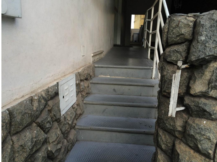
Imagem 2 – Portão menor de acesso ao Centro
