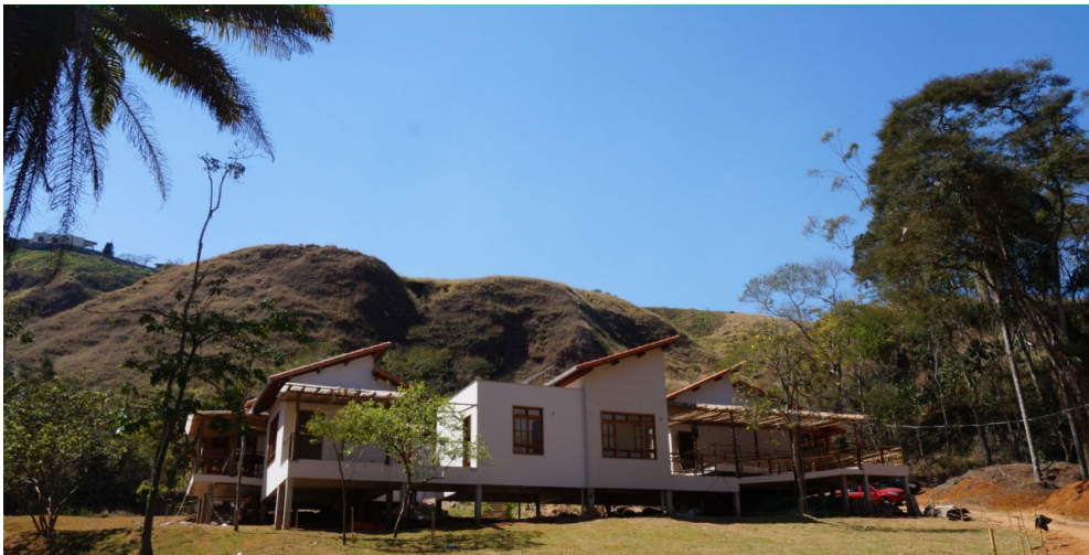
Figura 10 - Edificação em fase final de obras. Fonte: Acervo do ECOS
