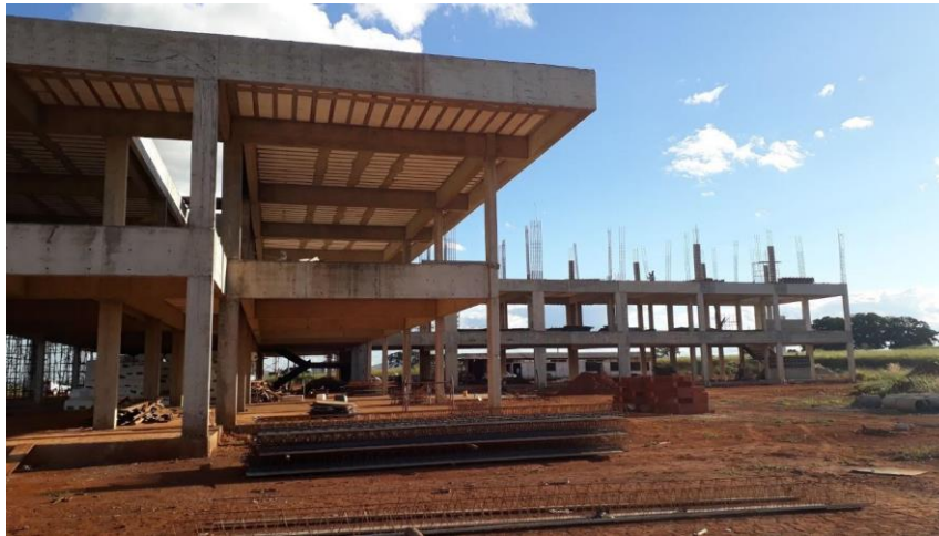
Figura 3. Vista parcial do canteiro de obras
