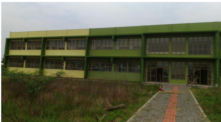
Figura 2. Imagem da entrada principal do Prédio de Laboratórios.
