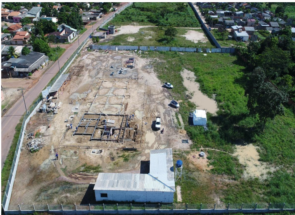
Fig.4. Construção da sede própria do Campus de Itaituba. Foto: Vitor Viana
