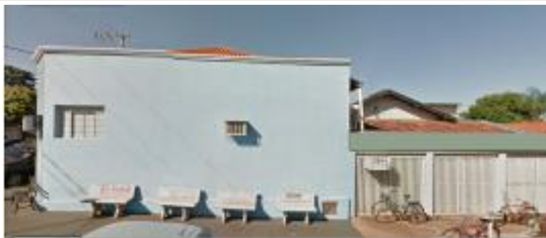
Figura 5. Frente da Unidade III.
