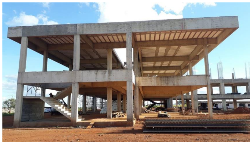
Figura 4: Vista parcial do canteiro de obras
