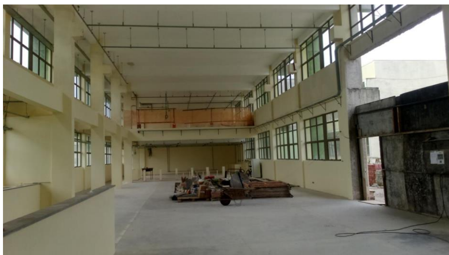
Figura 3. Imagem do interior do Prédio de Laboratórios - A.
