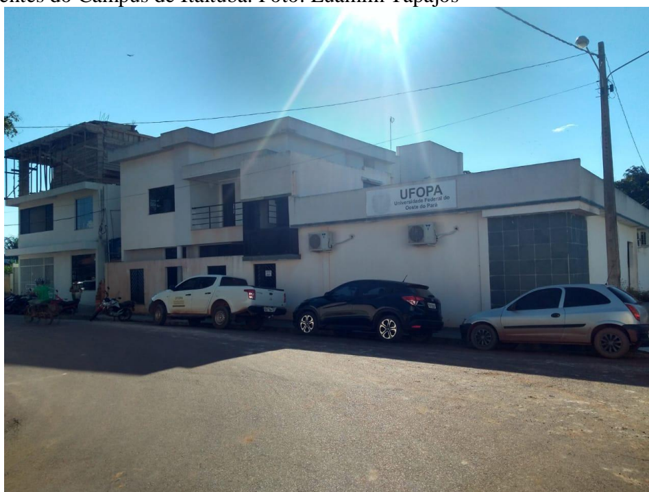
Fig.3. Sede alugada do Campus de Itaituba. Foto: Luamim Tapajós
