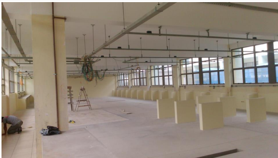
Figura 4. Imagem do interior do Prédio de Laboratórios - B.
