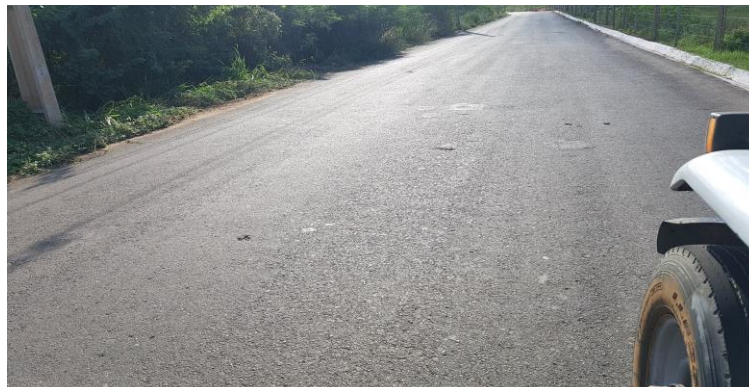
Figura 7 - Estrada de acesso ao IFMG pavimentada pelo DNIT utilizando material reciclado com drenagem lateral - Segmento 1 (foto comissão).
