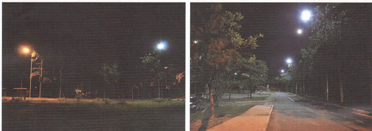
Figura 10: Fotografias da via estudada. Na foto da esquerda, LEDs e HPS lado a lado. Na foto da direita, HPS em primeiro plano (luz projetada na via) e LEDs ao fundo
