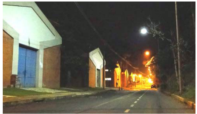
Fig. 7. Iluminação noturna de parte do anel viário com LEDs, em primeiro plano, e com VSAP, ao fundo.
