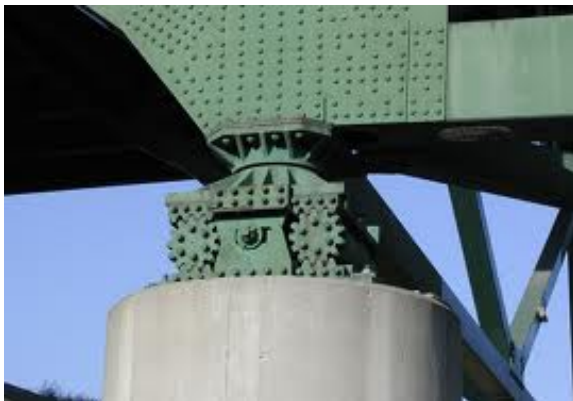
Figure : Apoio de 1 o gênero – detalhe.
