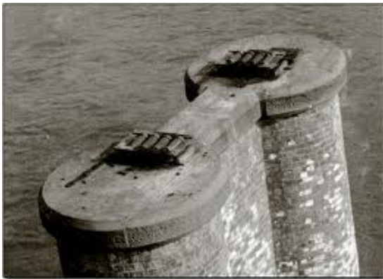
Figure : Apoio de 1 o gênero – construção.
