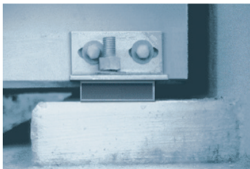
Figura: Apoio elastomérico de uma viga de ponte.
